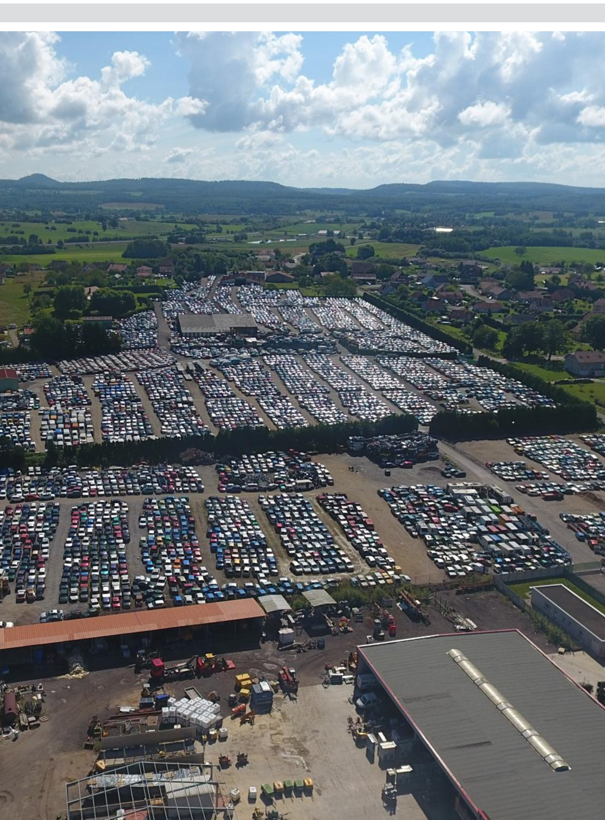
Au premier plan, les anciens bâtiments MCC Perney vont être transformés en bureaux et autres magasins de vente de pièces détachées. Photo DR
